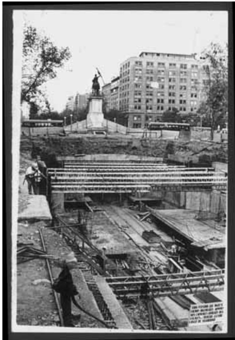
Construcción del Metro de Santiago. Alameda del Libertador General Bernardo O'Higgins. Fotografía F. de Silvestri, 1971. Colección Archivo Fotográfico. Museo Histórico Nacional.
