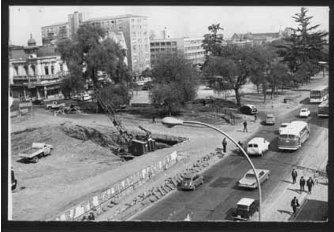
Construcción del Metro de Santiago. Alameda del Libertador General Bernardo O'Higgins. Fotografía F. de Silvestri, 1971. Colección Archivo Fotográfico. Museo Histórico Nacional
