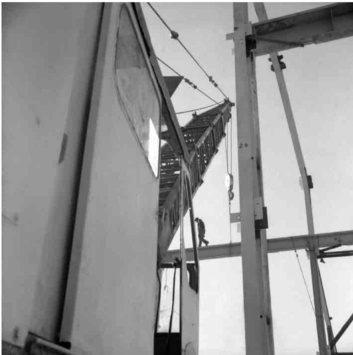
Un momento en la vida de un trabajador de la construcción. Mina El Algarrobo Valle del Huasco, Vallenar - c. 1962. MHN 3-40685
