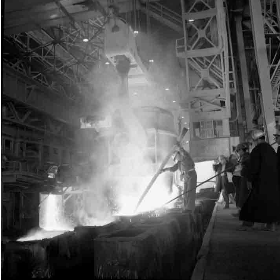
Moldeando acero en la Siderúrgica CAP de Huachipato Talcahuano - c. 1960. MHN 3-40681
