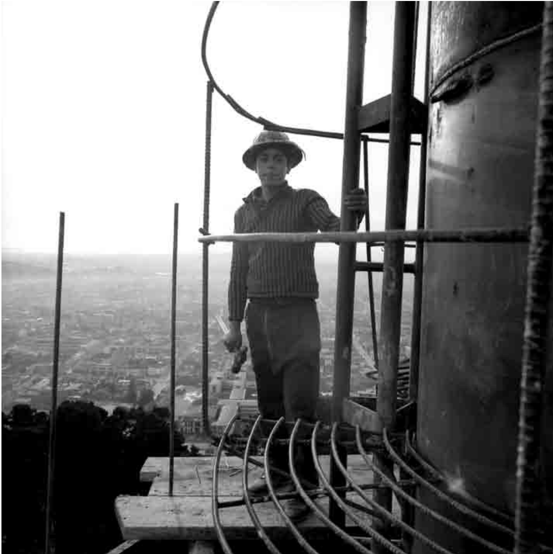
Obrero con martillo en lo alto de una estructura Santiago - 1970. MHN 3-40659
