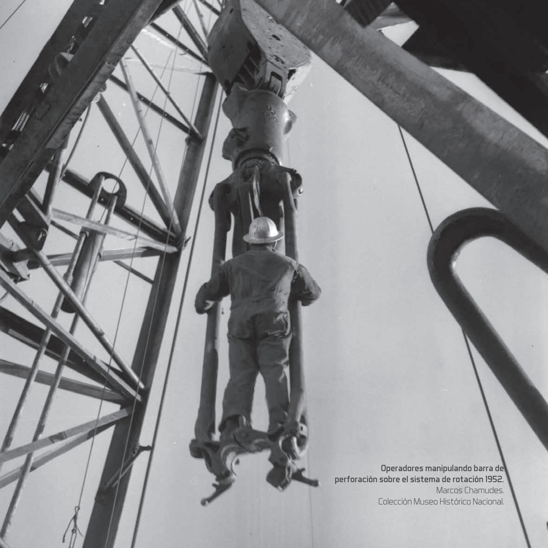
Operadores manipulando barra de perforación sobre el sistema de rotación 1952.
